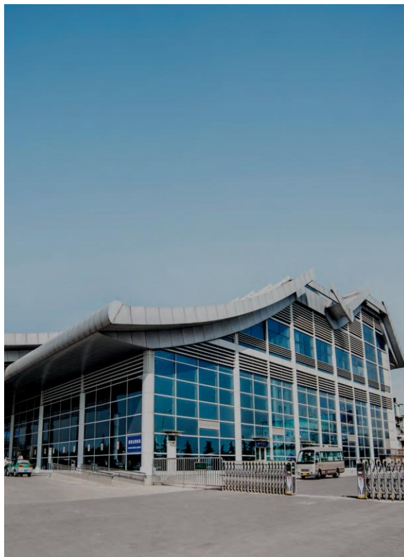
13 洛阳机场新航站楼
