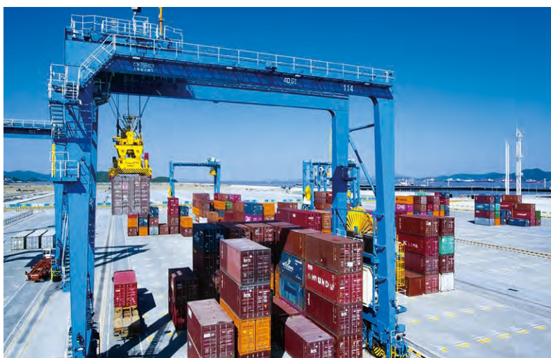
■ 寧波舟山港在國內率先實現 5G+ 遠控龍門吊批量投用
