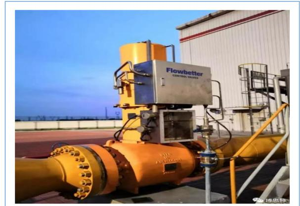
2020年7月14日，天津贝特尔流体控制阀门有限公司与中石油西气东输管道分公司联合研制的DN400 Class900压缩机防喘阀，成功通过中石油管道有限责任公司组织的现场工业性试验验收。
