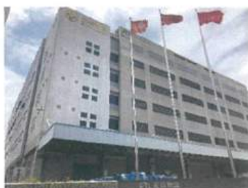
西侧——正佳盐田国际物流大厦
