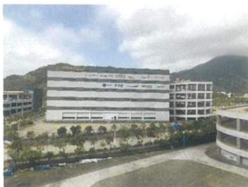
南侧-中通百富通现代物流园
