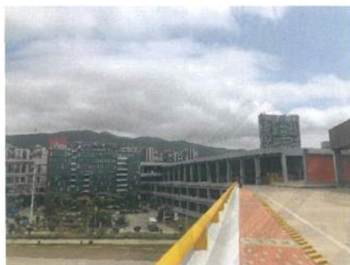
仓库/综合办公楼外观
