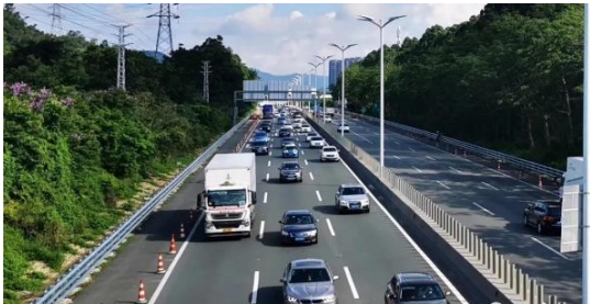
广深高速深圳段路灯项目
