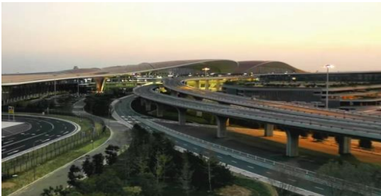
北京大兴国际机场路灯项目
