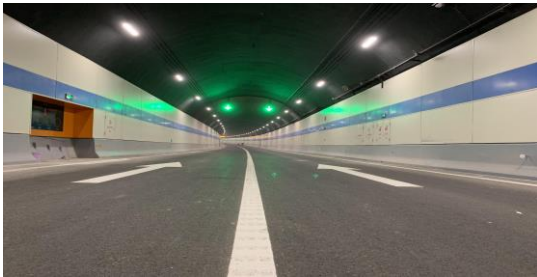
湖南常德沅江隧道工程项目
