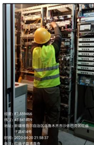
基站设备安装
