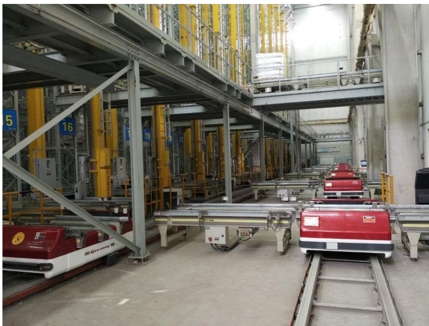
龙蟒佰利智能物流仓储项目实景图
