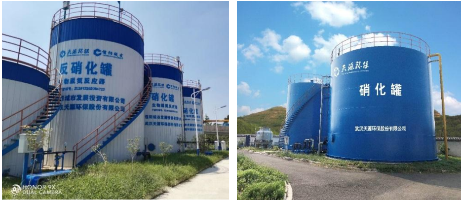
膜生物脱氮反应器实图
