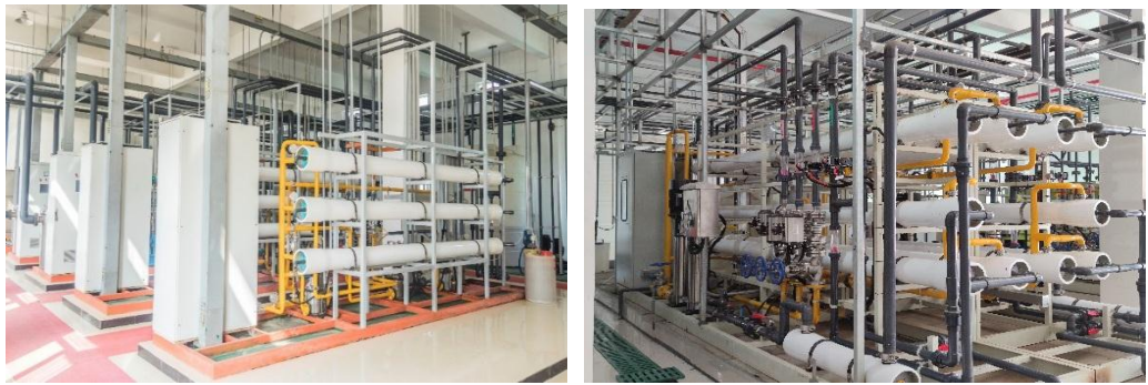
反渗透膜集成装置设备实图
