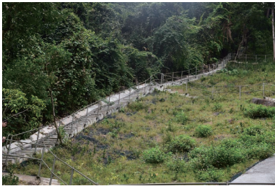
建造混凝土維護樓梯／通道
