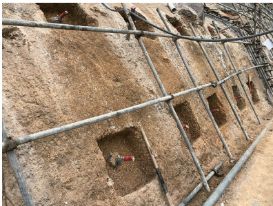
土釘鑽孔及安裝
