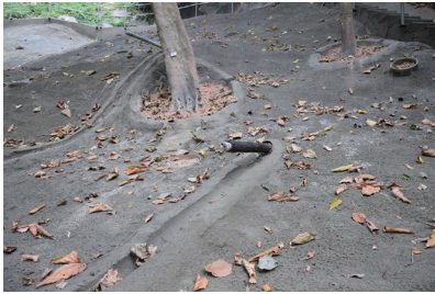
安裝排水斜管
