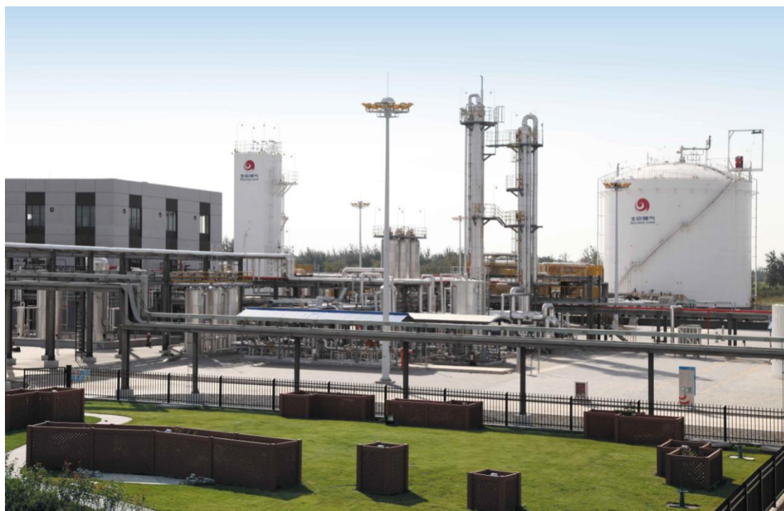
北京燃气集团 30 万方/日 LNG 项目
