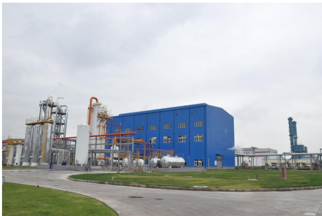
山西国新能源 50 万方/日 LNG 项目
