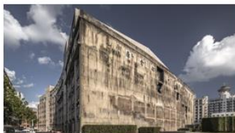
四行仓库 改造更新综合勘察与测评
