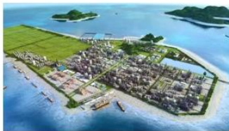
浙石化4000万吨/年炼化一体化项目（二期） 工程监理
