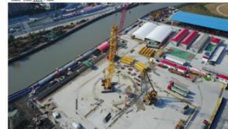
苏州河段深层排水管道系统工程 混凝土结构耐久性防腐技术质量检测、BIM咨 询、基坑围护检测
