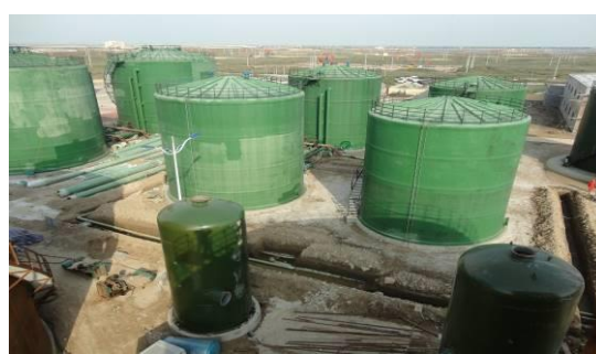
中石化胜利油田桩西采油厂污水回注系统建设工程
