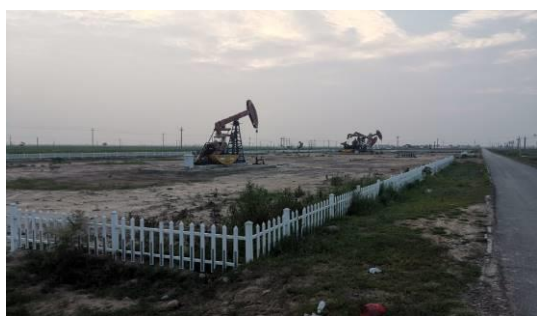
中石化孤岛油田南区渤 61 馆 5 稠油热采综合调整工程
