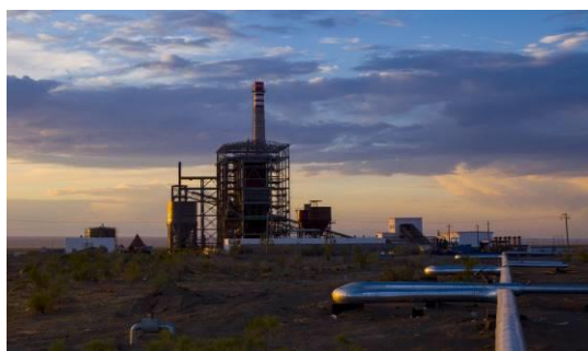
中石化新疆新春石油开发有限责任公司排 601-20 新区产能地面工程
