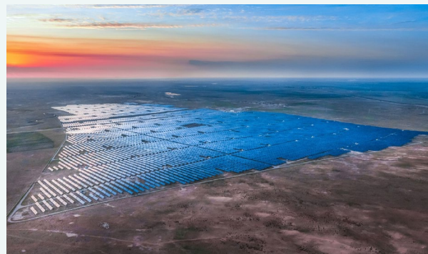
盐池电站全景图
