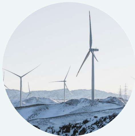
新疆木垒县大石头三风场 100MW 及五风场 200MW 地面集中式风力发电项目
