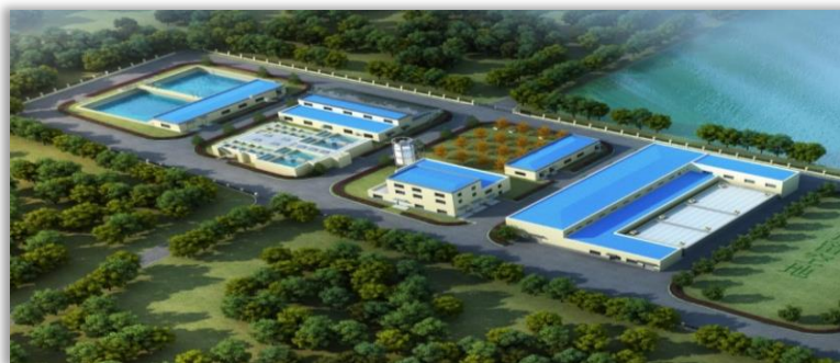
唐山瑞丰钢铁 4 万吨/天污水处理、回用及零排放 EPC 项目
