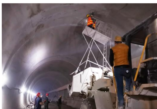
地质雷达检测隧道衬砌质量
