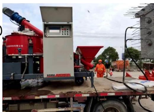
智能压浆系统现场应用图
