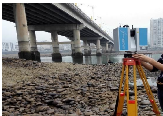
三维激光扫描快速无损检测桥梁病害
