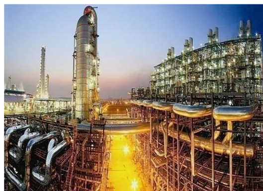
古雷炼化一体化项目
