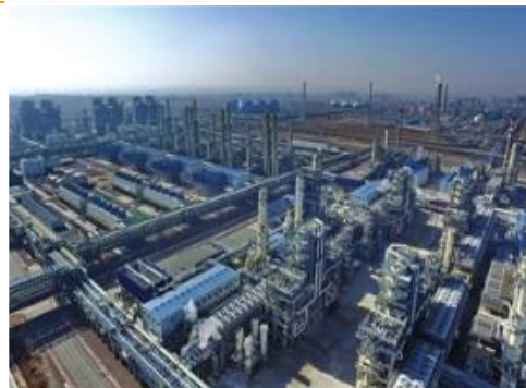
福建天汇 10 万立方丙烷储罐项目
