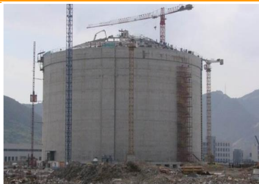
新奥舟山 LNG 接收站项目
