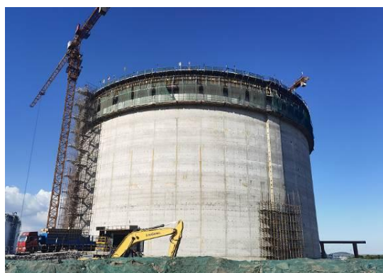
越南 HaiLinh Vung Tau LNG 储罐项目
