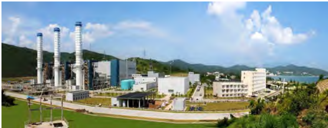
图 东部电厂（一期）项目外景
