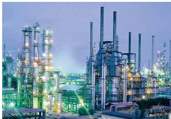
2018年-2022年 浙江石化炼化一体化项目
