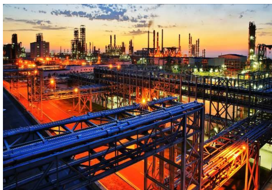
2019年-2020年 中石化中科炼化一体化项目
