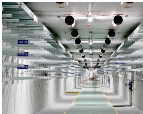
地下综合管廊
