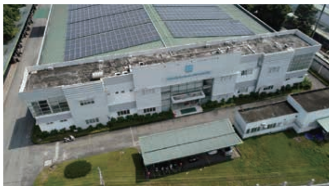
越南工廠的太陽能光伏系統
