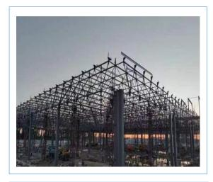
2022 年 6 月,公司承接的奥迪一汽新能源汽车总装车间工程开工,公司对工程施工做出全面、系统规划,安装方法采用整体顶升方案,严格进行网架吊装的荷载计算及吊装过程的整体控制与协调。目前该项目按照施工进度有序进行。
