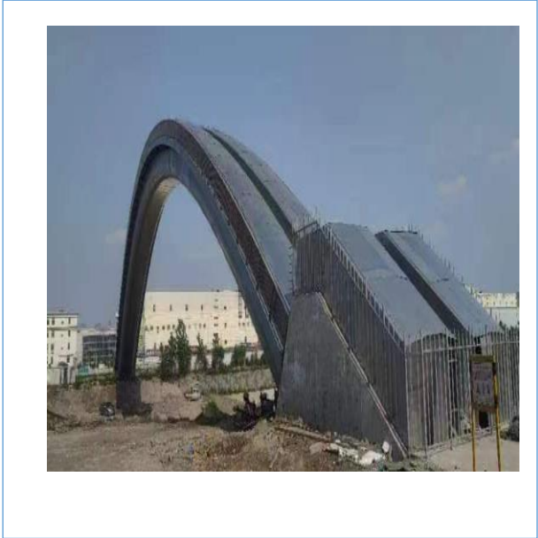
公司承接的桥梁钢结构制作顺利通过验收。
