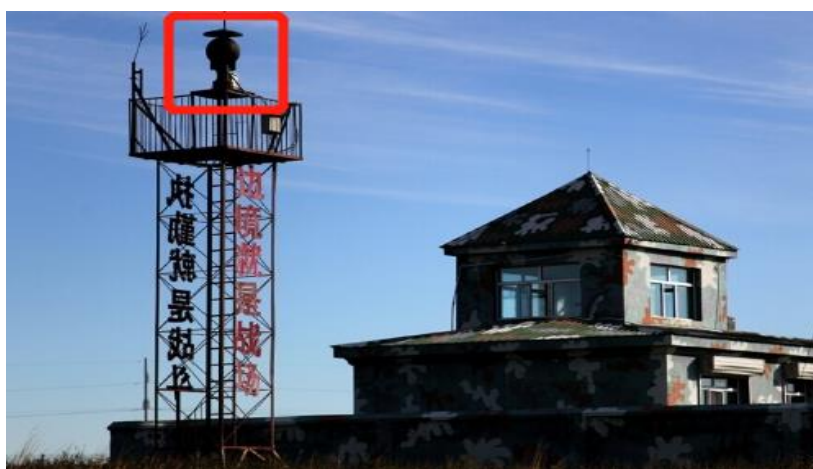
图：超长焦镜头在智慧边海防基础建设中的应用
