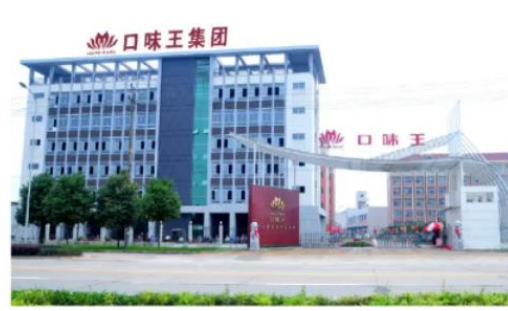
口味王集团配电工程
