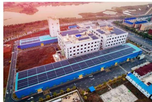
兴嘉生物望城分公司微电网项目
