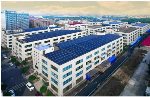
东方电子微电网项目
