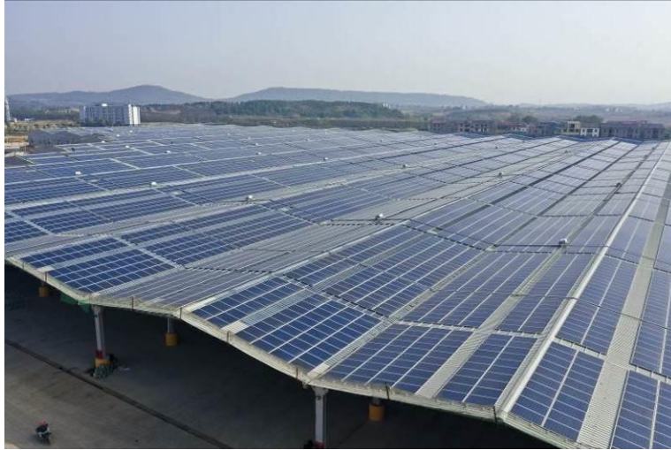
发行人江西丰城生产基地光伏厂房
