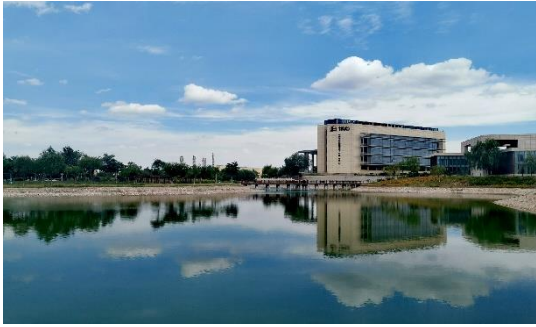
宁东中石化工业园区
