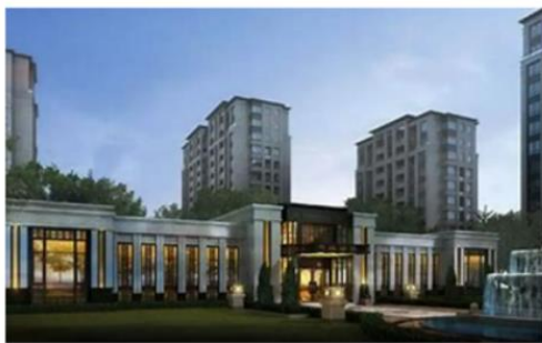
保利大都汇四期项目高低压配电工程
