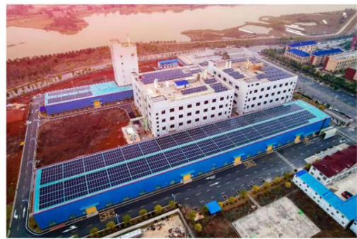
兴嘉生物望城分公司微电网项目
