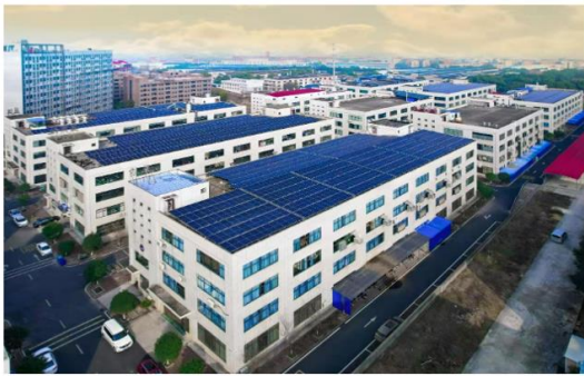
东方电子微电网项目
