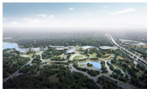
益阳一园两中心智能配电工程
