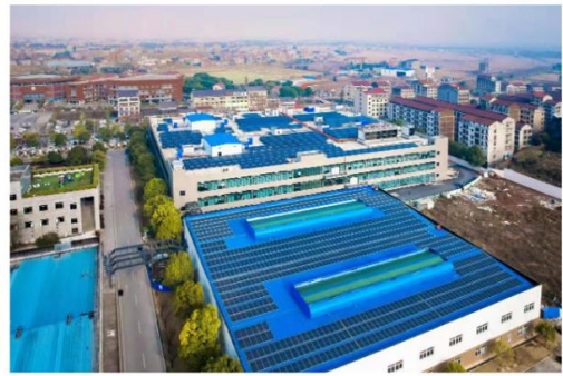
艾华集团微电网项目
