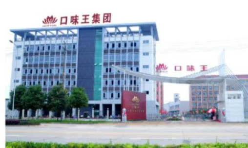
口味王集团配电工程
