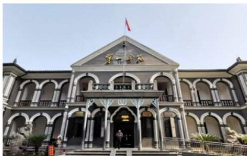
湖南第一师范学院配电工程
