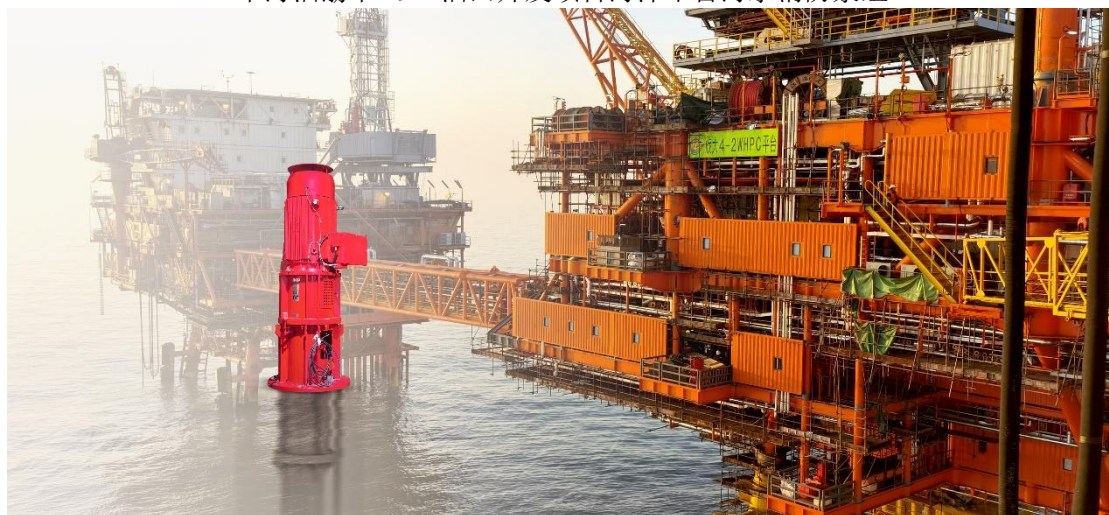
中海油旅大 4-2 油田开发项目海洋平台海水消防泵组
