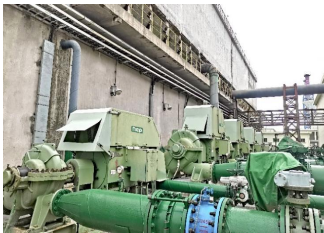
宝武集团湛江厚板 4200 项目中开泵
