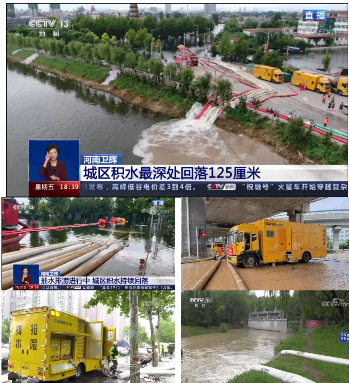
图示：2021 年 7 月河南郑州地区发生特大暴雨灾害，郑州、安阳、新乡、鹤壁等地被大面积积水淹，公司移动应急供排水装备在各灾区排水抢险救灾中发挥了重要作用。
