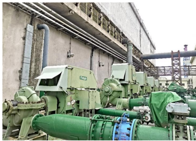
宝武集团湛江厚板 4200 项目中开泵
