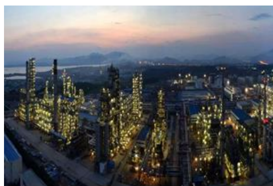
2022 年至今 安庆石化 800 万吨/年炼化一体化项目智能照明项目
