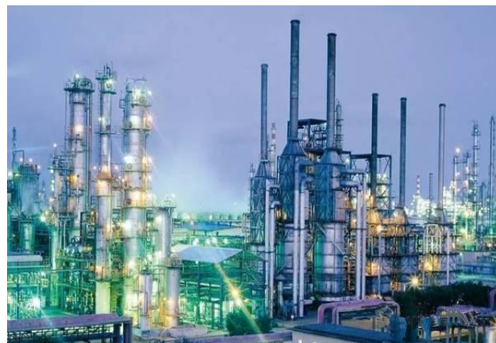
2018年-2022年 浙江石化炼化一体化项目
