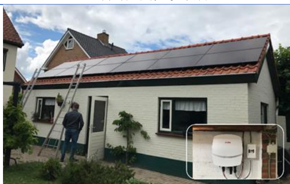
荷兰户用光伏项目
