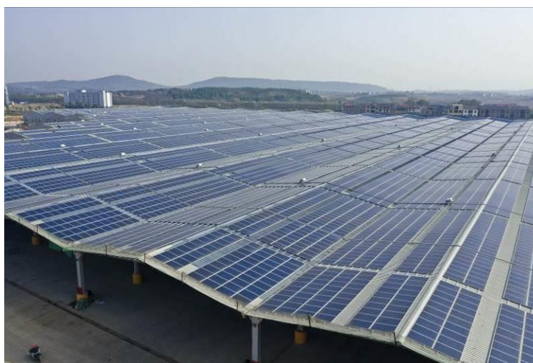
发行人江西丰城生产基地光伏厂房
