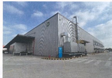
估价对象内部
