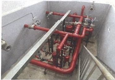
估价对象内部
