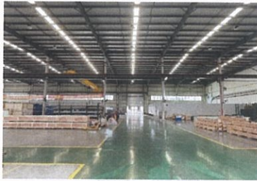
估价对象内部
