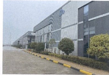
估价对象内部
