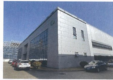
估价对象内部
