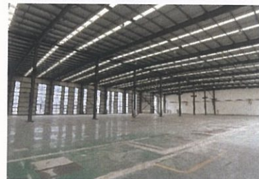
估价对象内部
