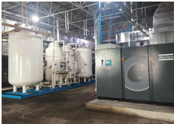
【空压制氮系统改造】
