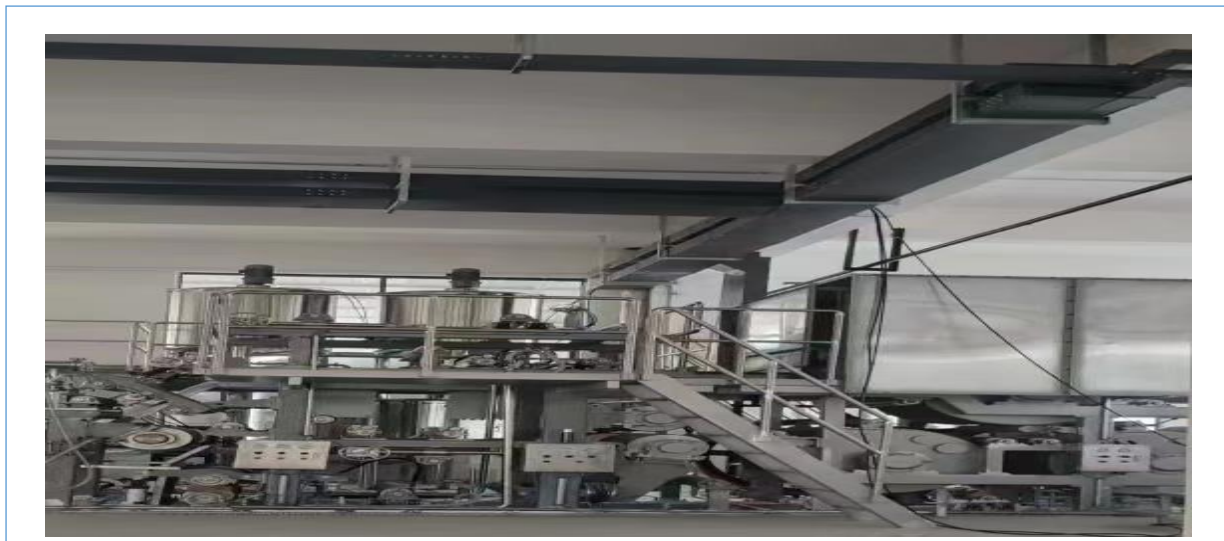
※公司高性能对位芳纶特种纸新项目主体设备陆续开始安装
