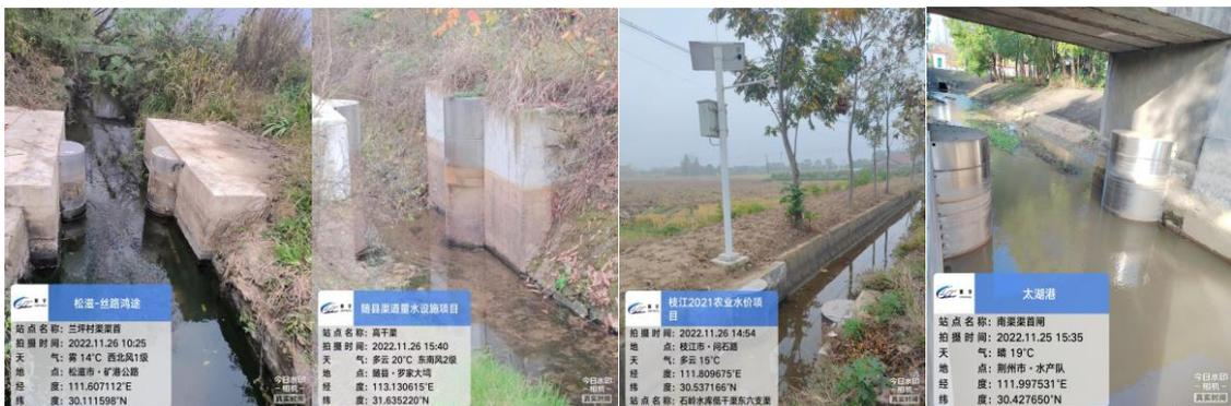
2022年11月，公司组织技术人员，对在湖北省的约200处武汉联宇智能明渠量水器站点进行巡查维护。设备维护前，站点上线率约为87%。巡查维护后，经过一周的运行观测，数据上线率为99%，数据正常，在本次巡查维护中看到，武汉联宇智能明渠量水器站点受渠道复杂情况的影响很小，在有淤泥、水草、落叶杂物、静止余水等典型渠道中仍能可靠运行，精确计量。
