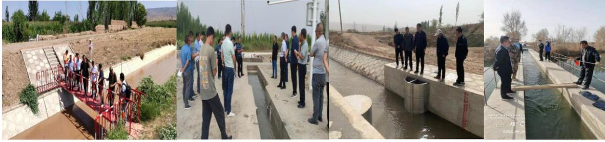
2022年4月至8月，公司智能明确量水设备先后在宁夏引黄渠道七星渠站点、新疆第三师8连1号闸站点、宁夏七星渠站点、新疆第二师31团站点等多个站点开展现场比测工作。通过多处比测结果分析，智能明渠量水器实测流量数据与人工转子流速仪实测流量数据非常接近，误差较小，实测精度达到国家验收要求。
