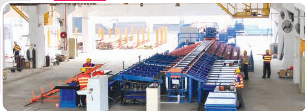
香港大埔之鋼筋自動化加工工場
