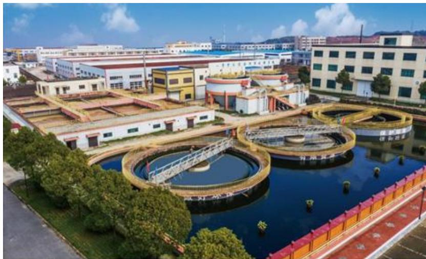
图示 发行人中水回用系统实景图
