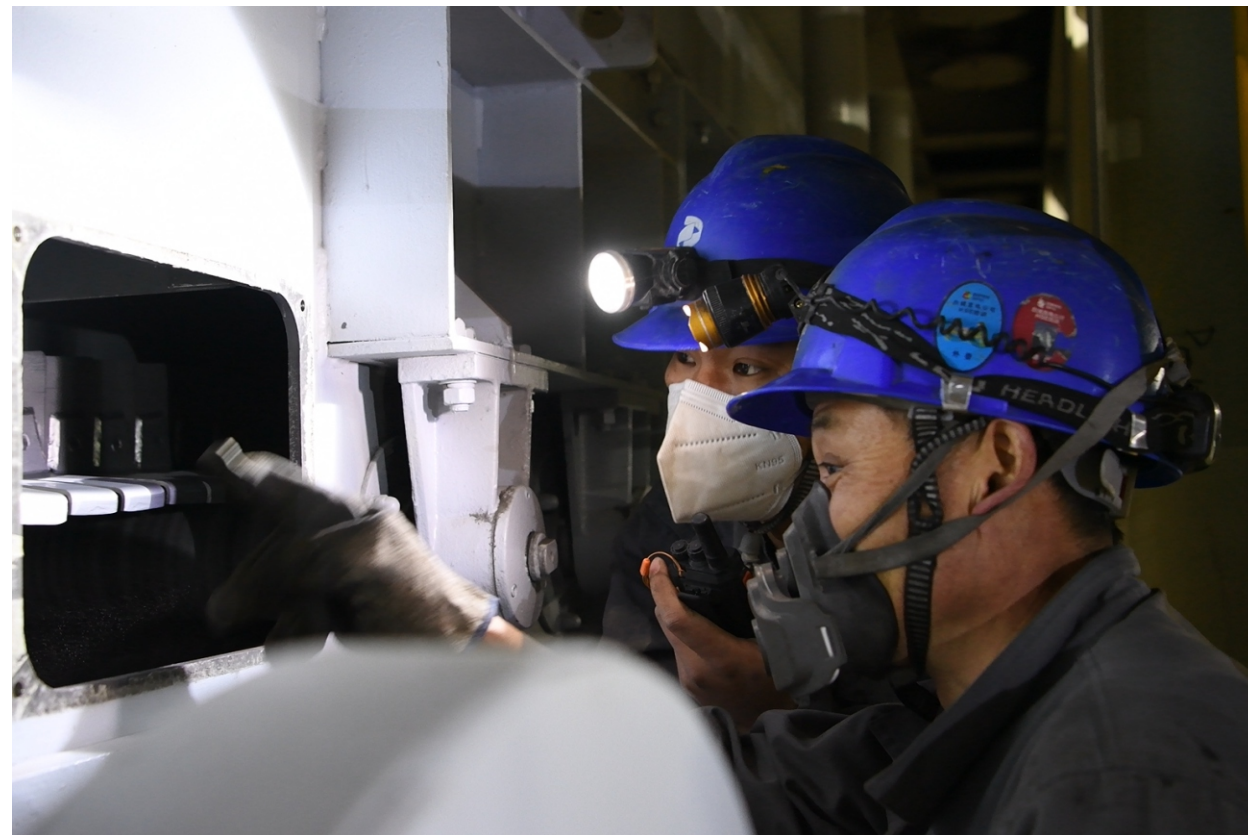
白城发电公司正在进行2号炉干排渣机钢带检查
