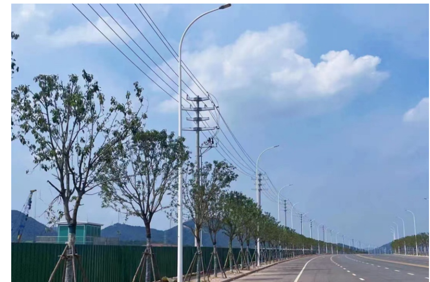
安庆高新区增量配电网首条10kV供电线路
