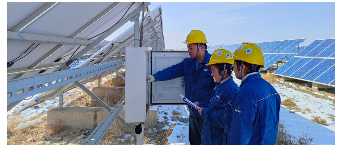
西北区域公司高台光伏电站春节期间进行光伏子阵设备检查
