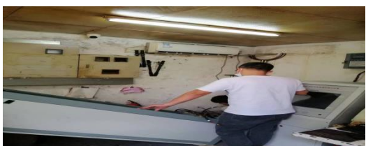
银座物业全方位更换消防自 动报警系统，保障公共安全
