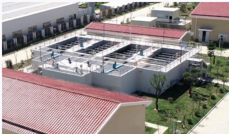
位於福州市長樂區污水處理廠
