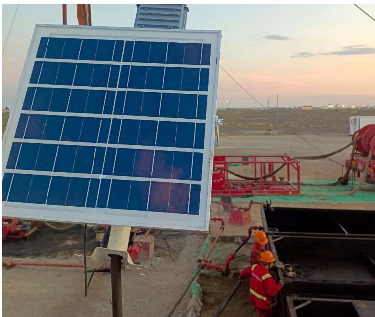
新疆業務部連續油管四隊在AHHW2xx井鑽磨橋塞作業，現場安裝太陽能戶外照明燈
