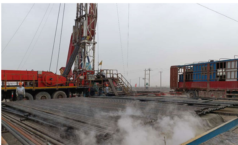
新疆業務部吐哈小修108隊在神xx 井通刺原井油管，地面鋪防滲布及圍 堰，確保污水不落地
