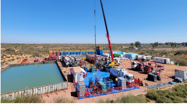
DX-PXX平台壓裂施工現場
