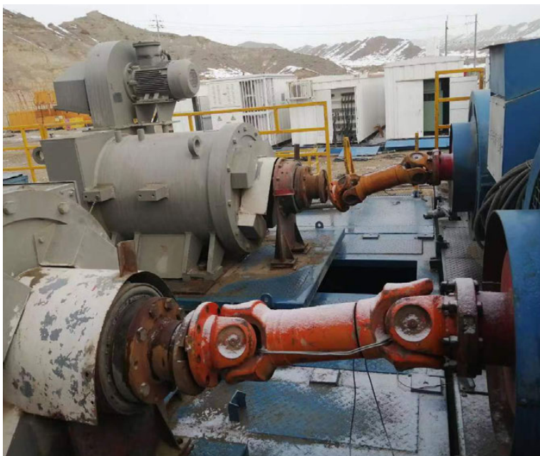
塔里木業務部50型鑽機改造為雙燃料發動機
