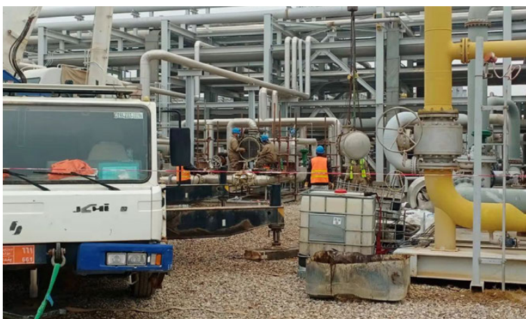
中北伊業務部綠洲油田運行項目部 CPF站區修理清水撬，管線污水回收 不落地
