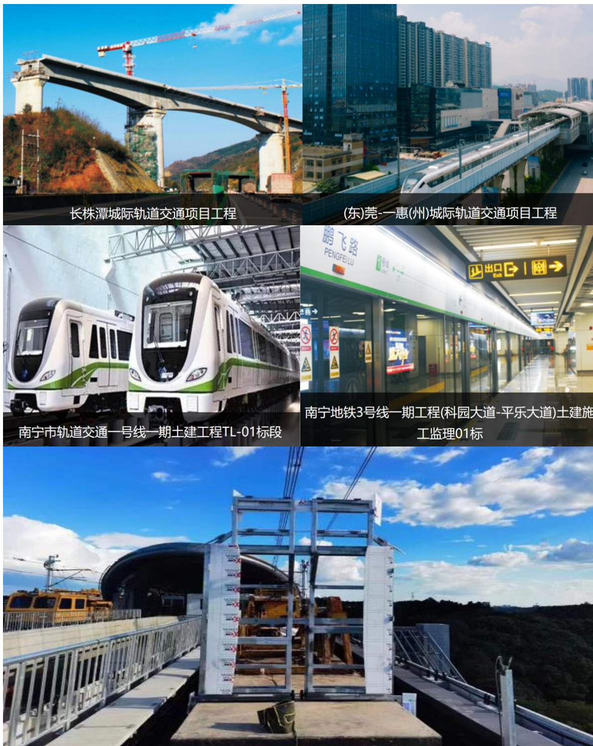
图：长株潭城际轨道交通西环线一期工程
