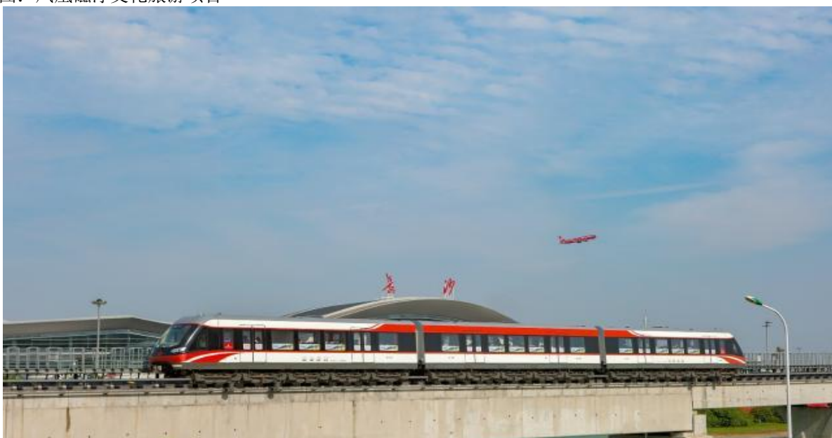
图：长沙磁浮工程
