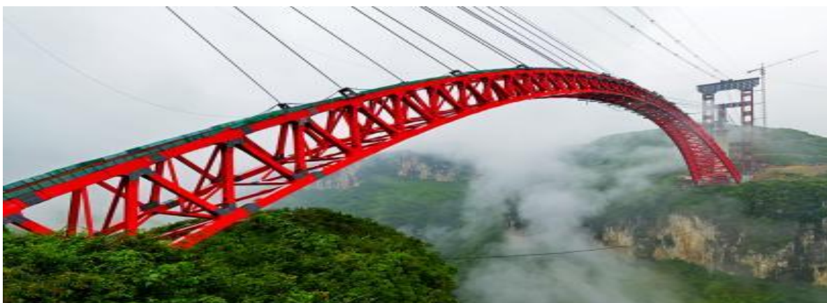
图：新建林（歹）至织（金）铁路纳界河特大桥
