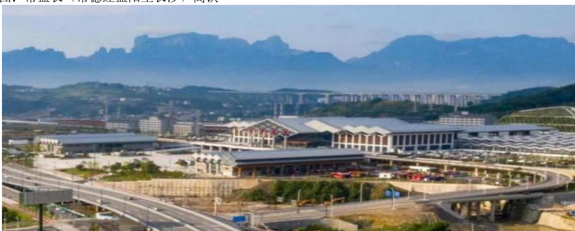
图：黔张常（黔江至张家界至常德）铁路张家界西站
