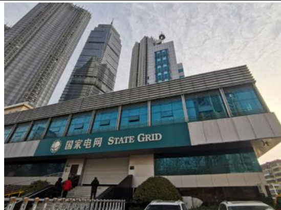
国家电网烟台供电公司调度大楼消防自动报警等系统维修项目
