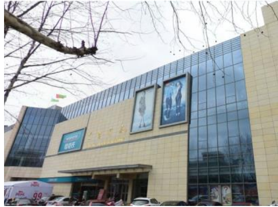
莱阳商厦西园餐厅消防工程
