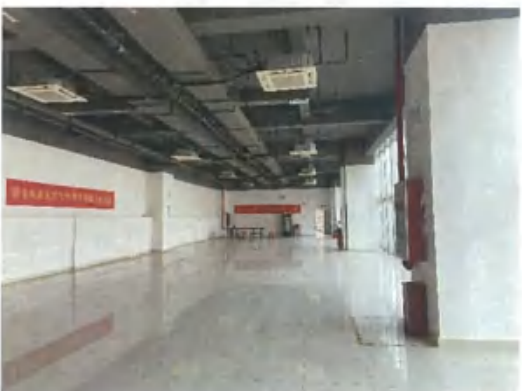
估价对象内部5
