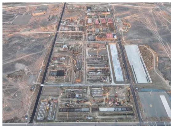
2022 年至今 新特硅基新材料有限公司一期多晶硅项目
