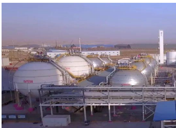
2022 年至今 宁夏润阳硅材料科技有限公司一期高纯晶硅项目
