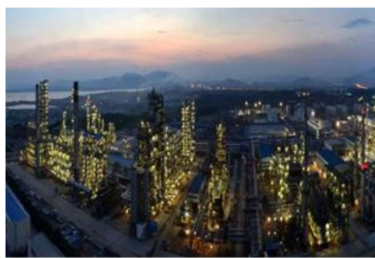
2022 年至今 安庆石化 800 万吨/年炼化一体化项目智能照明项目
