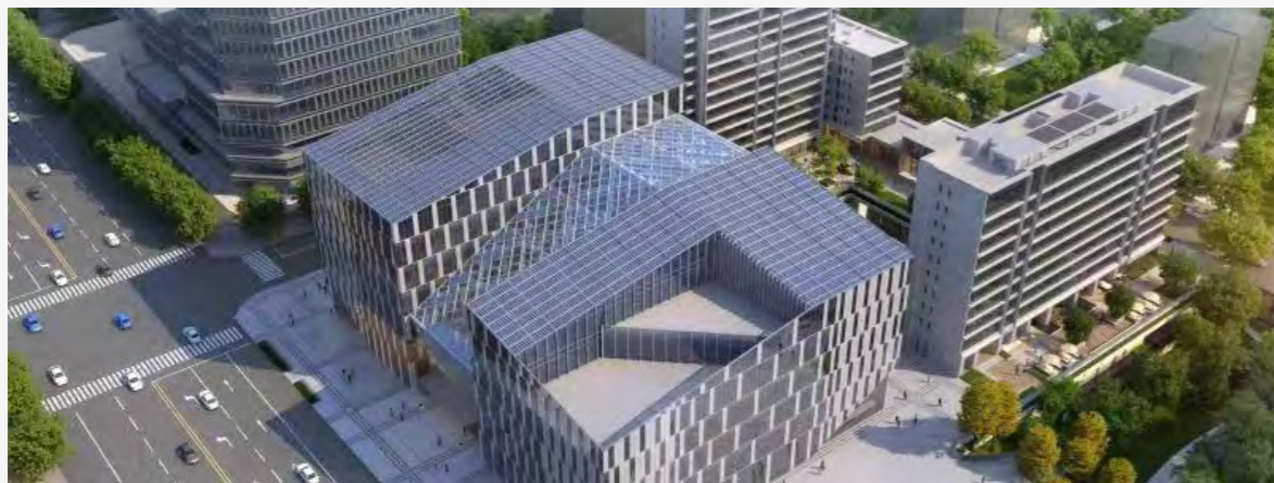
雄安建筑楼顶光伏
