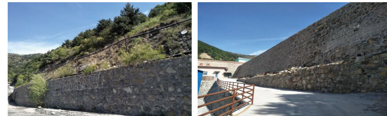
边坡治理工程
