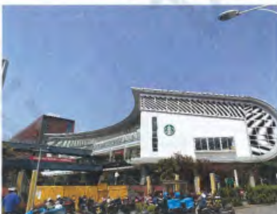
配套综合楼外观
