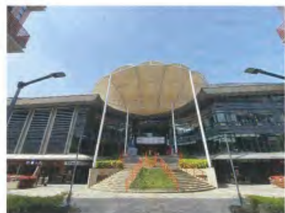
配套综合楼外观
