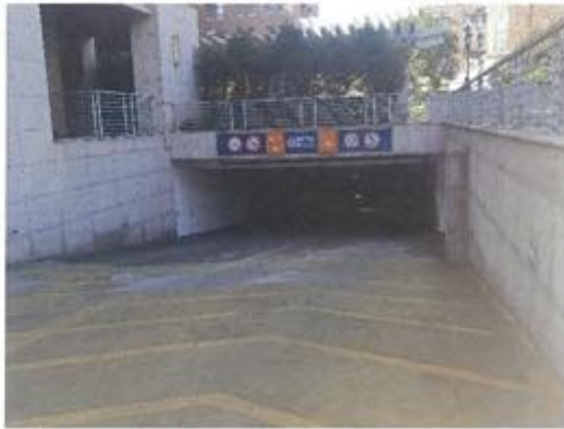
估价对象车库入口
