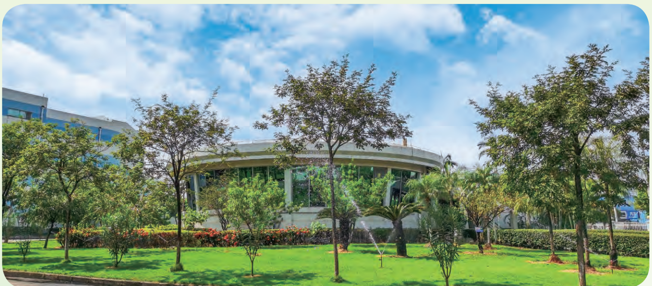
位於偉易達工廠的雨水收集系統
