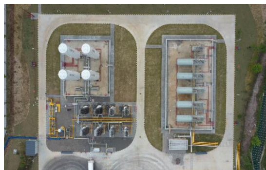
东阳市横店燃气总站
