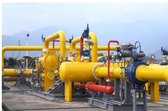
金华市区天然气高压输配工程
